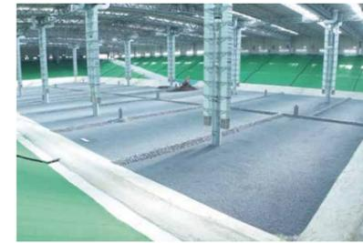
屋根が廃棄物の飛散や雨水の侵入を防ぐからいつでも安全に埋立ができるよ。施設の底には何種類ものシートを敷いて廃棄物で汚れた水が漏れるのを防いでいるよ。
