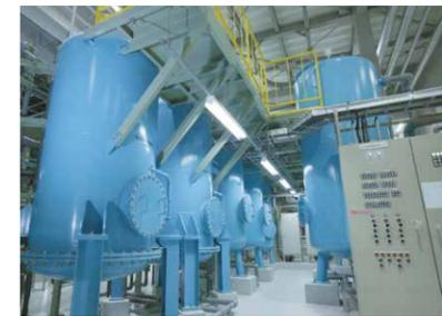
汚れた水を薬品や微生物で浄化しているよ。浄化した水は散水用としてまた再利用するんだよ。
